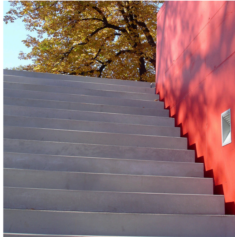
BETONOVÉ ZDI A PREFABRIKÁTY
