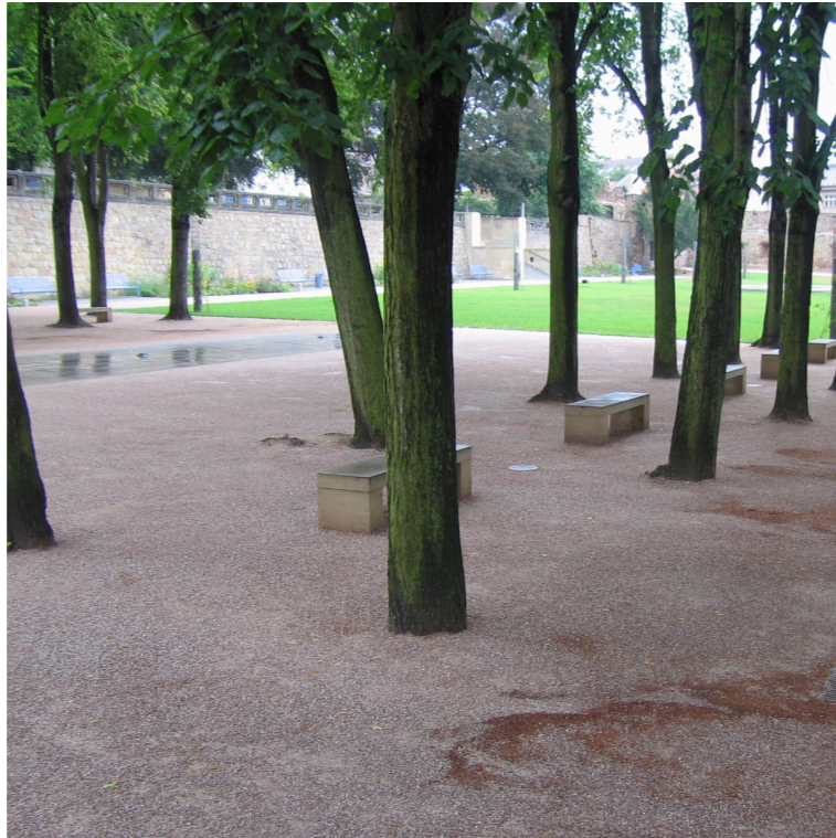
MECHANICKY ZHUTNĚNÉ KAMENIVO
