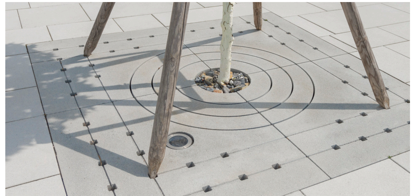
Betonová mříž - bosket před Domem kultury
